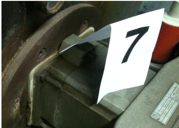
Figura 34 - guarnizione locale caldaia
