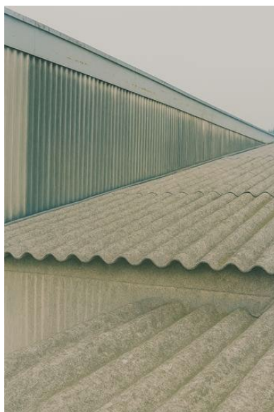
Figura 6 - copertura esterna con lastre in cemento amianto
