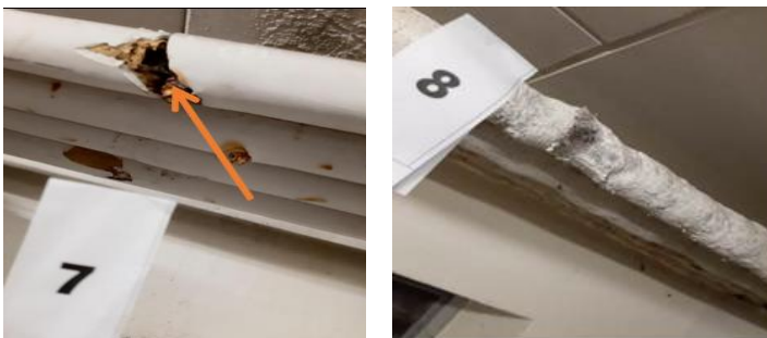
Figure 42 - prelievo del campione massivo da coibentazione di tubazioni
